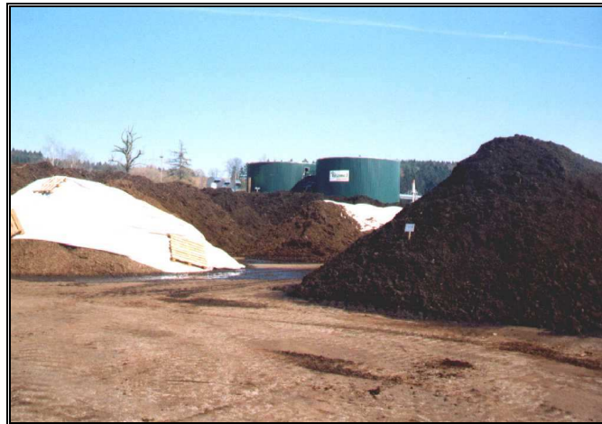
Foto 2: Pohled na bioplynovou stanici kombinovanou s kompostárnou v Teugnu, SRN
