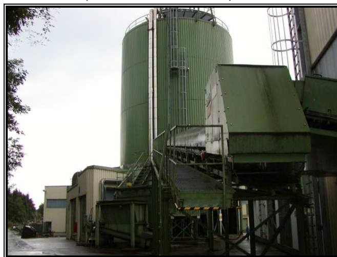
Obr. 1: Bioreaktor typu Dranco v Salzburgu (fotka z archivu TS ZLín)
